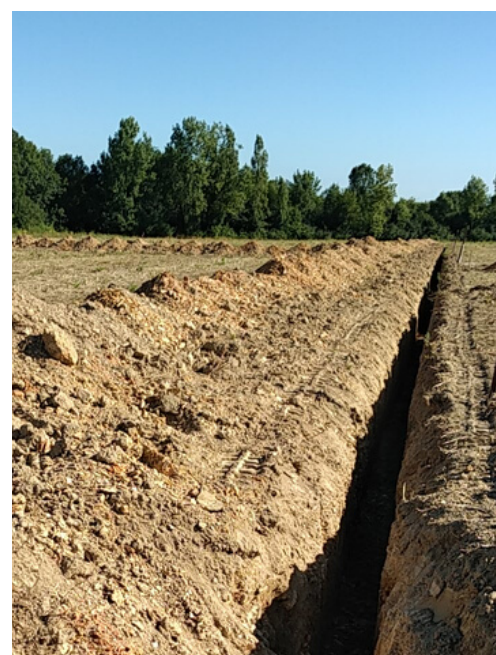
Le début des travaux pour l'irrigation
